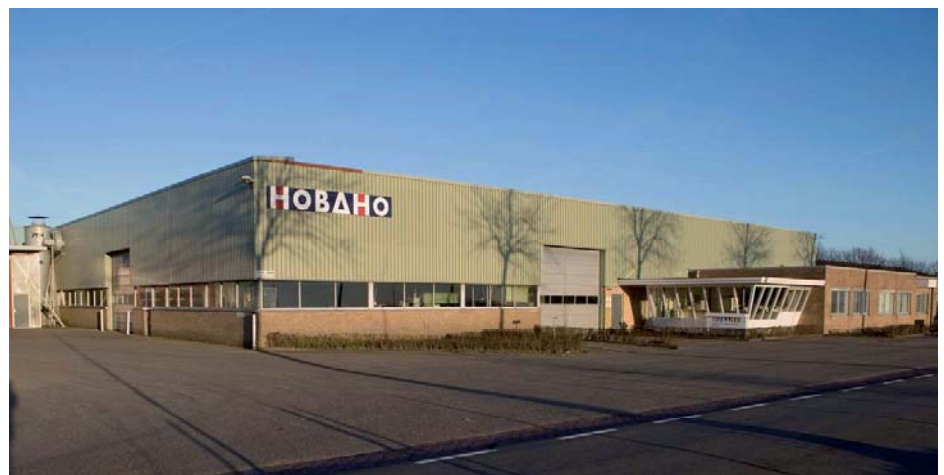
Het koel- en preparatiebedrijf in Hillegom
