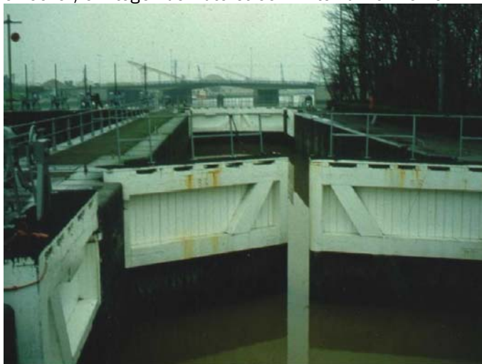
Figuur 7-d De sluisen in de IJzer bij Nieuwpoort vormen weliswaar een barrière voor het selectief getijden transport, maar geven de glasaal nog volop gelegenheid door de kieren en spleten naar binnen te zwemmen.
