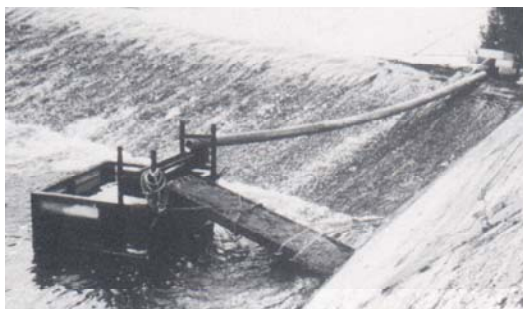
Figuur 5-b Een conventionele pootaalval. Water stroomt via de pijp naar de hellingbaan gevuld met wilgentenen. Deze val staat bij Adara in de Maigue (Ierland). In Vollenhove loopt de aanvoerslang over een hoge dijk.
