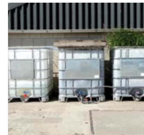
▲ Met enkele kuubs vaten is snel en goedkoop een eigen reinigingssysteem te bouwen.
