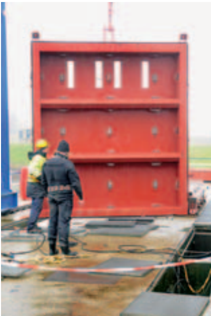
Afbeelding 1: De terugslagklep met de vier openingen voor de vismigratie in het bovenste vizier.
