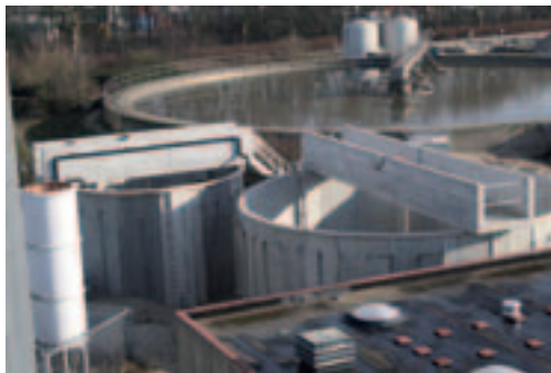
Twee nieuwe buffertanks voor de opslag van extern aangevoerd dun dan wel dik surplusslib.
