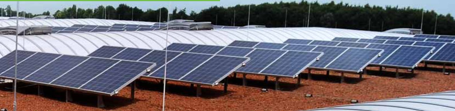
Als de plantjes op het dak straks tot wasdom zijn gekomen, dragen ze bij aan extra efficiency van de zonnepanelen.
