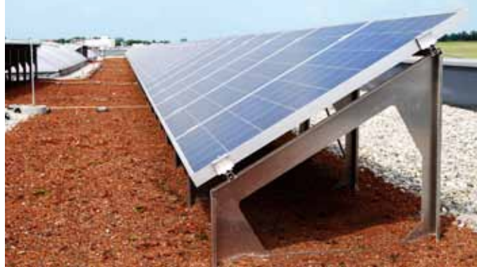
Als de plantjes op het dak straks tot wasdom zijn gekomen, dragen ze bij aan extra efficiency van de zonnepanelen.
