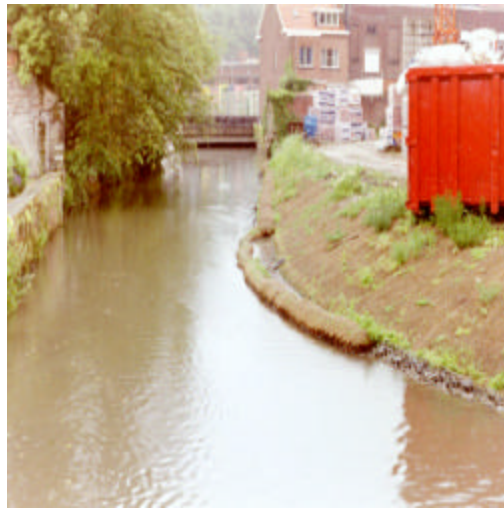
Aanleg natuurvriendelijke oevers Leuven
