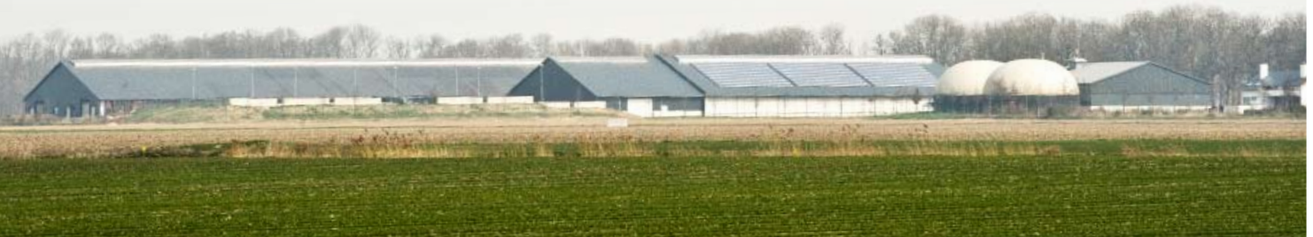
Mestvergister (rechts) levert digestaat voor de diepstrooiselbox
