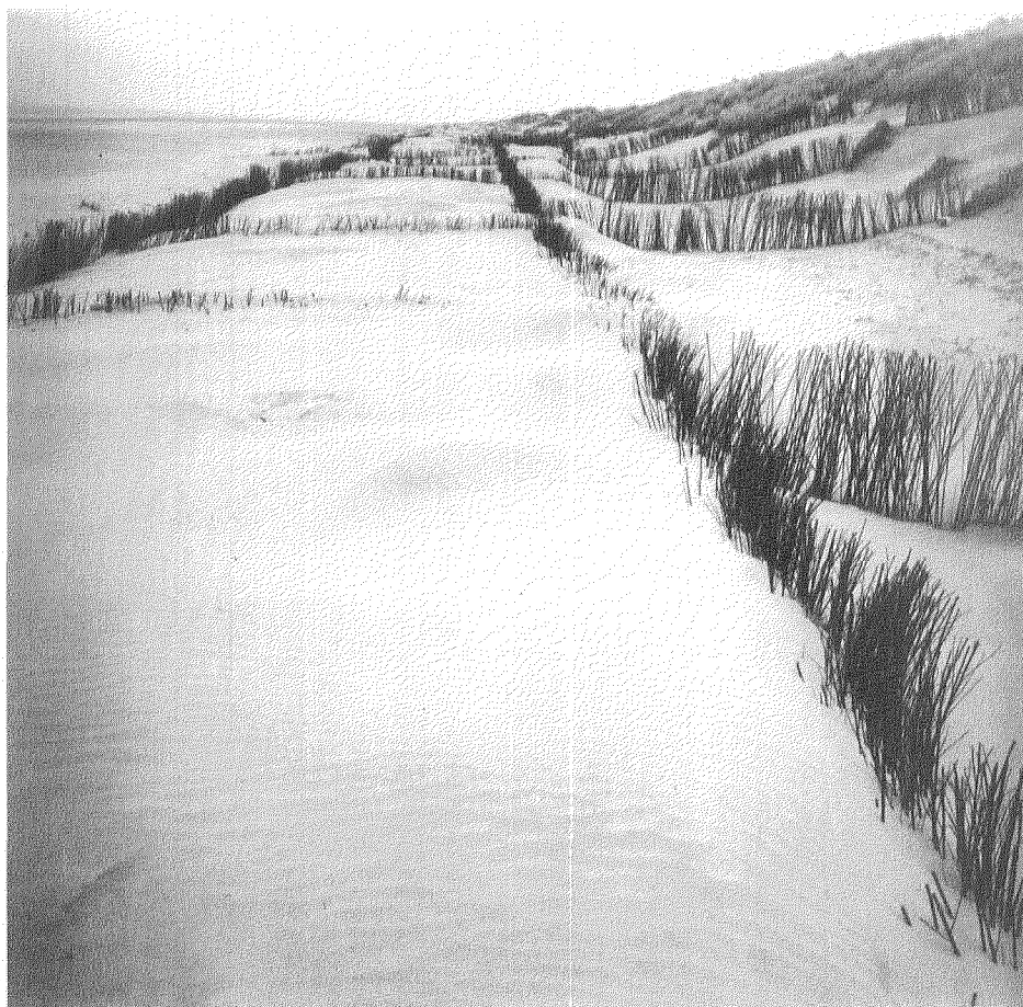
Stuifdijk aan de noordzijde van een waddeneiland. Door het steeds opnieuw plaatsen van rijshoutschermen wordt stuivend zand vastgelegd.
