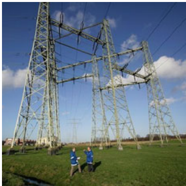
Foto 1: Vakwerkmast - Kruising of splitsing van een hoogspanningslijn.
