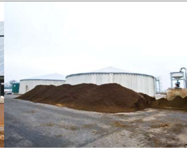
De mest gaat eerst in de vergister en wordt daarna gescheiden
