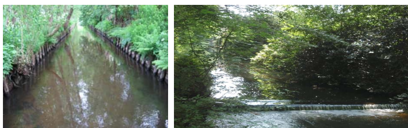
Figuur Grift in beschoeiing, vismigratiebarriere (rechts)
