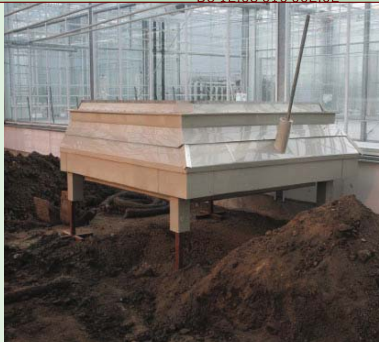
Afgebouwde prototype vlak voor het in de grond ingraven.
