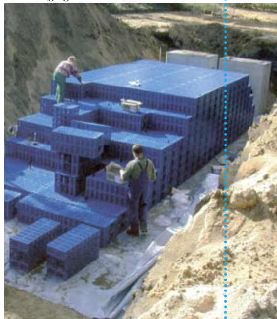
infiltratiekoffers voor bodempassage
