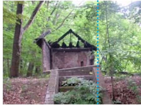
renoveren/conserveren beekgerelateerde bebouwing
