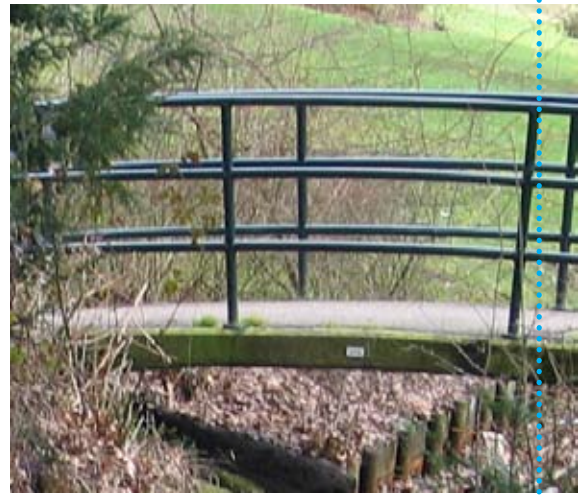
brug: beton, van insteek tot insteek
