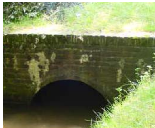
kunswerken (duikers, waterverdeelpunten etc.): baksteen, duikers met circelvormige inlaat
