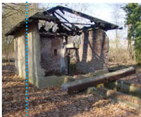
renovatie/ conserveren beekgerelateerde bebouwing
