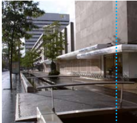
continuïteit beek: Nieuwe Kestersbrug
