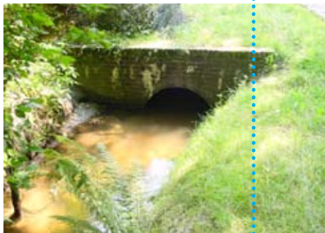
continuïteit van de beek: zichtbare duikers.
