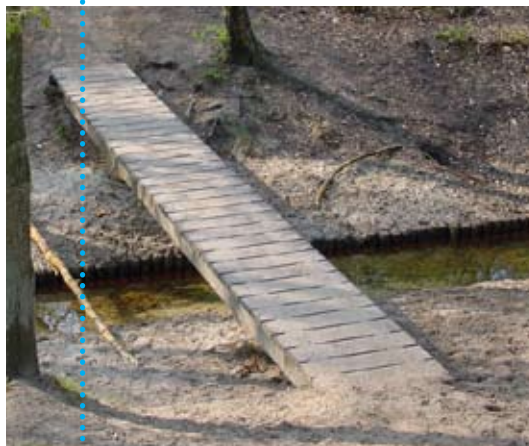
informele brug: hout, nabij het waterniveau
