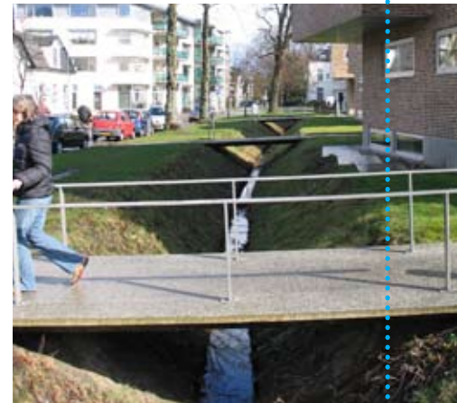
brug: beton, van insteek tot insteek
