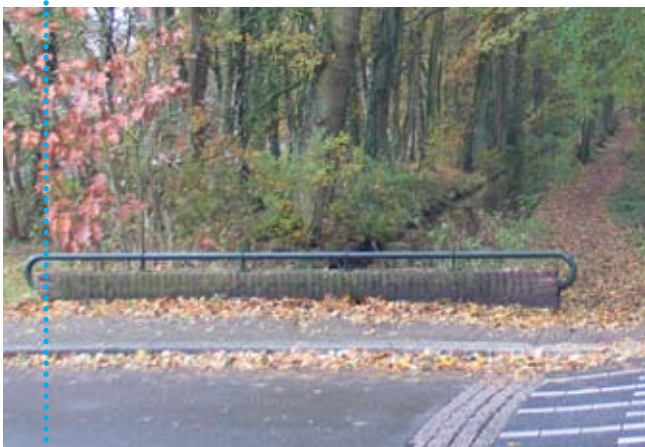
brug voor auto's: duiker met baksteen muur, metalen frame en rooster in de weg
