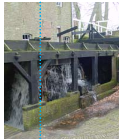
renoveren: oude functie herstellen (museum)
