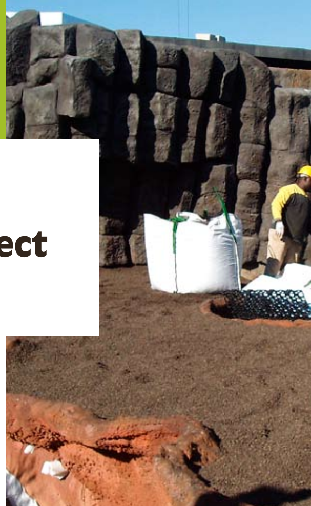
ZinCo Daktuinsubstraat komt bovenop het systeemfilter SF
