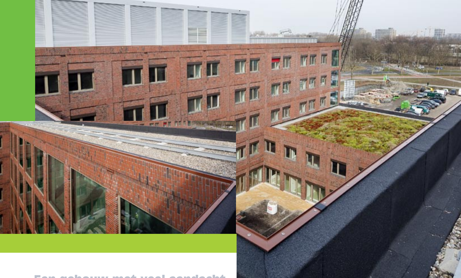
Het Maasstad Ziekenhuis in aanbouw
