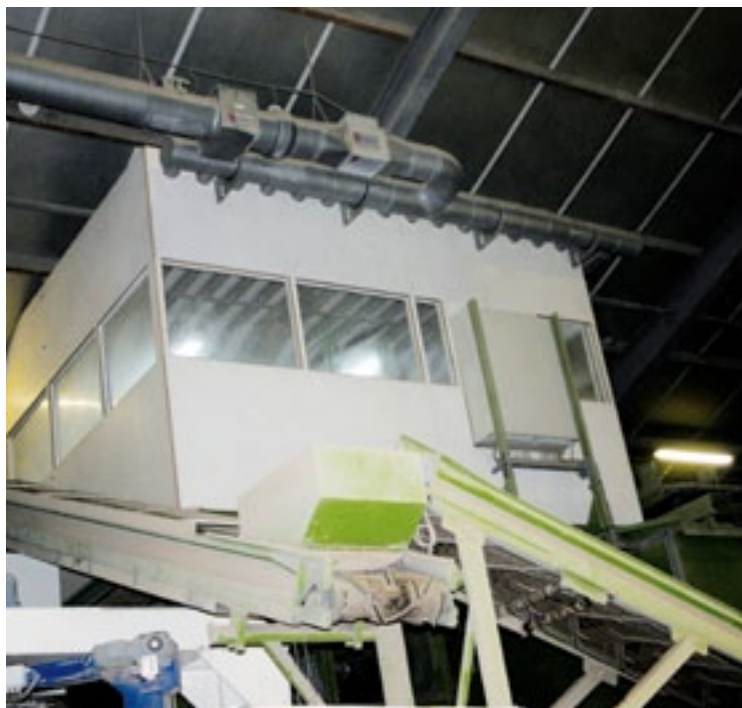
▲ Na het opwarmen wordt de lucht via de hoofdbuis verdeeld en in kleinere buizen geblazen.
