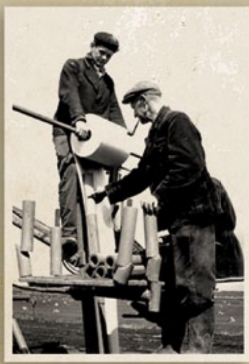
Links: De toepassing van glasvezel als omhullingsmateriaal in plaats van turf-molm is nieuw bij het draineren. Onder: De nieuwe cultivator van Lely kenmerkt zich door torsietaafvering en de bijzondere verkruiemelrol.
