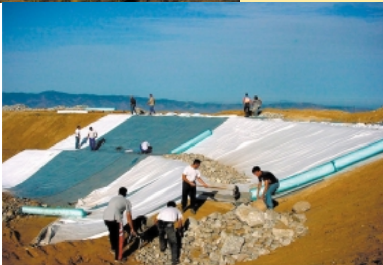
Aanleg van de oevers van een kunstmatig meer
