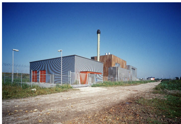
Figuur 8 Biomassaverbrandingsinstallatie in Lelystad (1,7 MW e )
