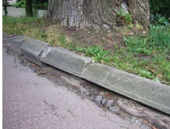
Foto 4 Opsluitbanden op hout gefundeerd
