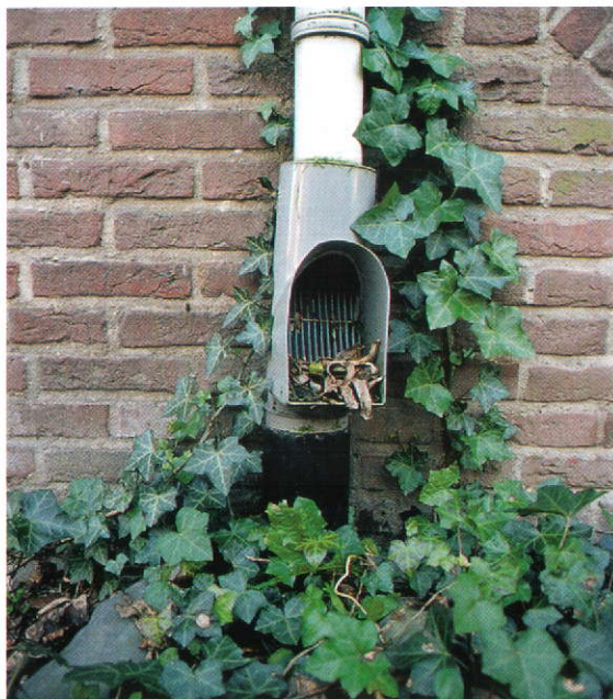
Afgezaagde regenpijp met bladvanger.
