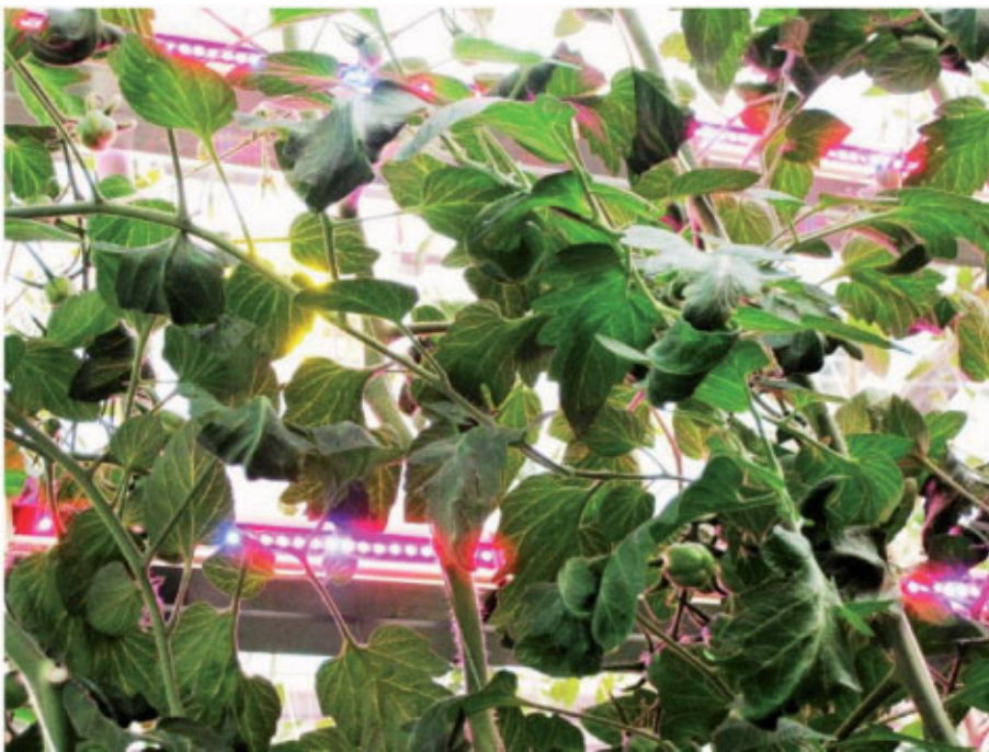
Overzicht van 2 rood-blauwe LED-armaturen tussen het gewas.
