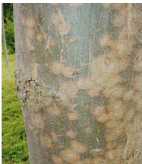
Soort: Plum-es Soort aantasting: Afsterven buitenste cellagen Risico: Geen dilatatie / scheuren
