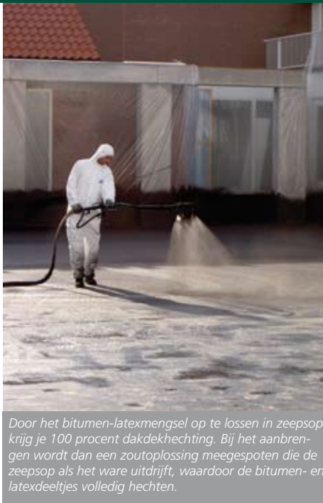
Hechtingsmateriaal voor dakdekking: een teerachtig materiaal, traditioneel opgebracht door verhitting. Het kleeft wel, maar hecht niet superstevig.
