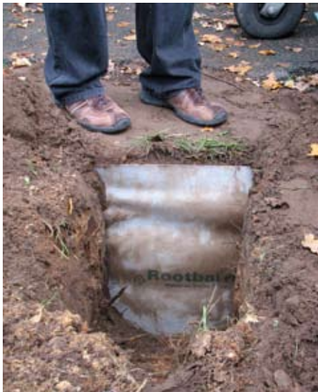
Opgegraven RootBarrier®-wortelweringsscherm.
