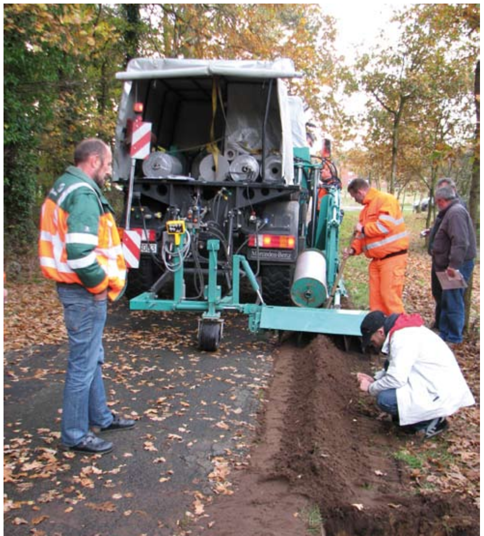
De laatste losse grond krijgt een plekje bovenop de sleuf.
