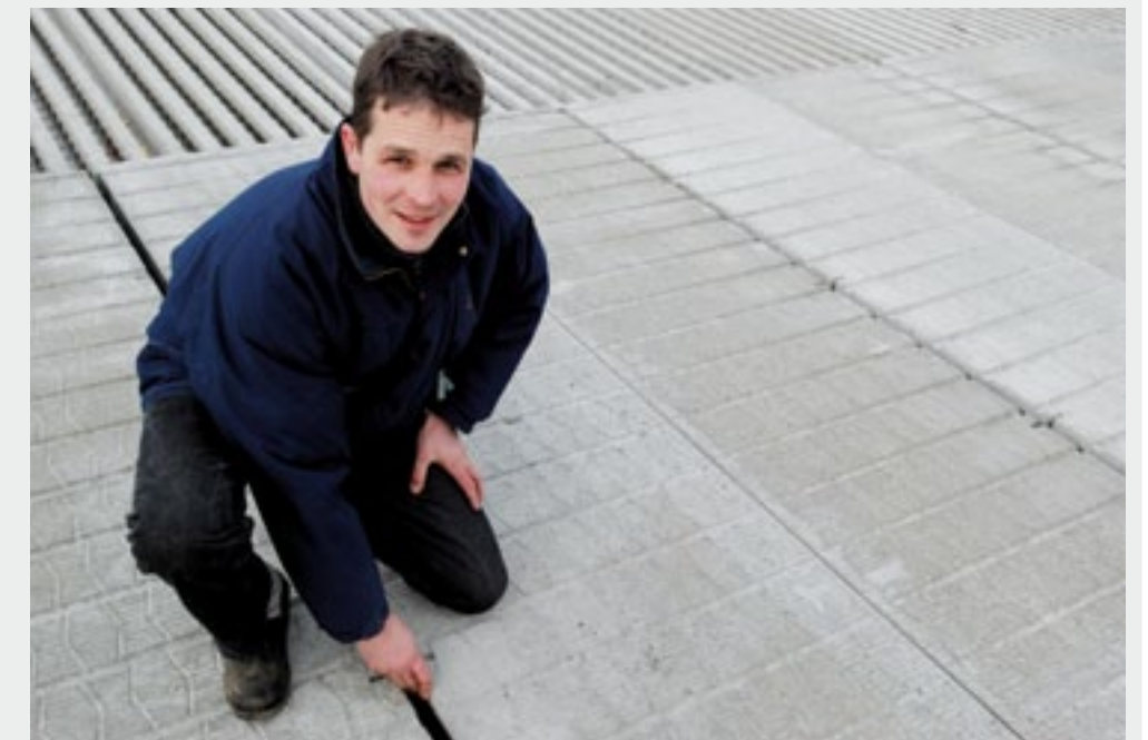
Melkveehouder Joost van Eert laat de emissiearme vloer van Swaans Beton in zijn nieuwe ligboxenstal leggen.
