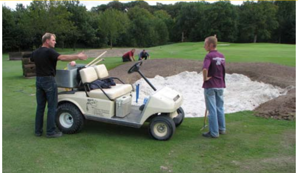
Wim Oskam geeft aanwijzingen bij de renovatie van de bunker.
