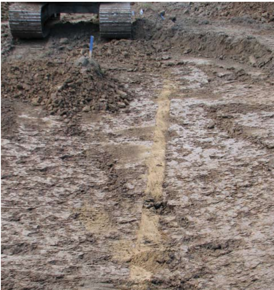
Drainagekanalen in de rivierklei.
