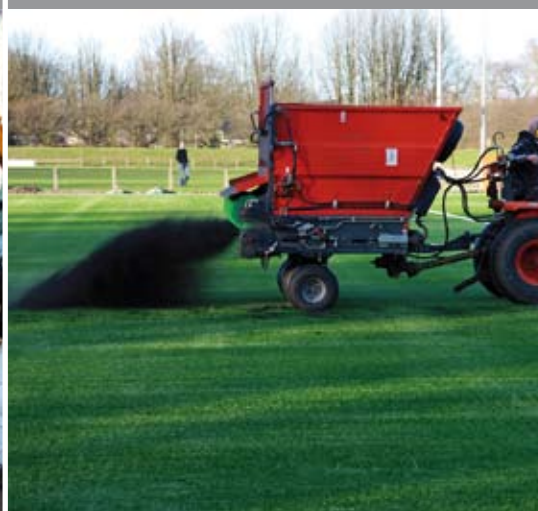
Uitstrooiing van het rubber-infill over het veld.
