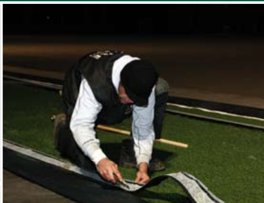
De randen –waarmee de veldrollen aan elkaar kunnen worden genaaid maar die bij lijmen overbodig zijn- worden eraf gesneden.
