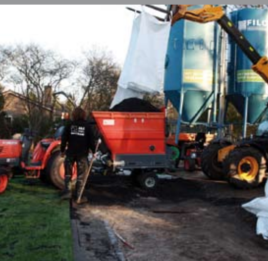
De SBR-infill wordt geladen om uitgestrooid te worden over het veld.
