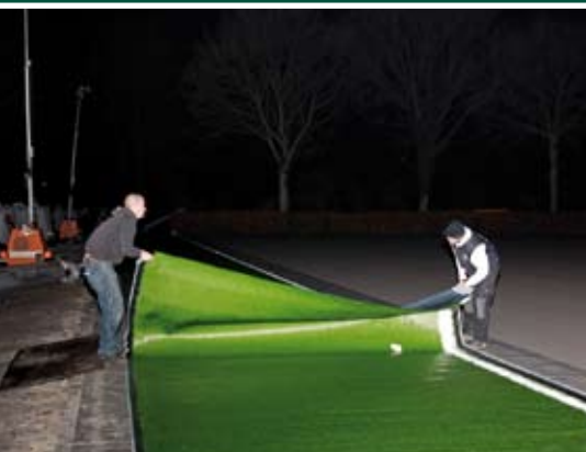
Het leggen van het geotextiel en het leggen van de buitenkant van het veld. Om het veld is een tegelpad gelegd; daar gaat de eerste veldrol tegenaan.
