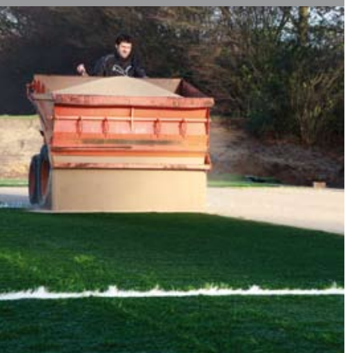
Opbrengen van het zand. Dit is rond zand, want scherp zand zou de kunstgrasvezel kunnen beschadigen.
