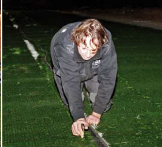
De banen worden aan elkaar gelegd. Dit is een heel secuur werkje, want de vezels mogen niet onder de lap geraken.
