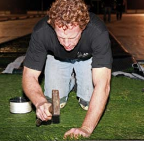
Uitrollen en vastleggen van een baan.
