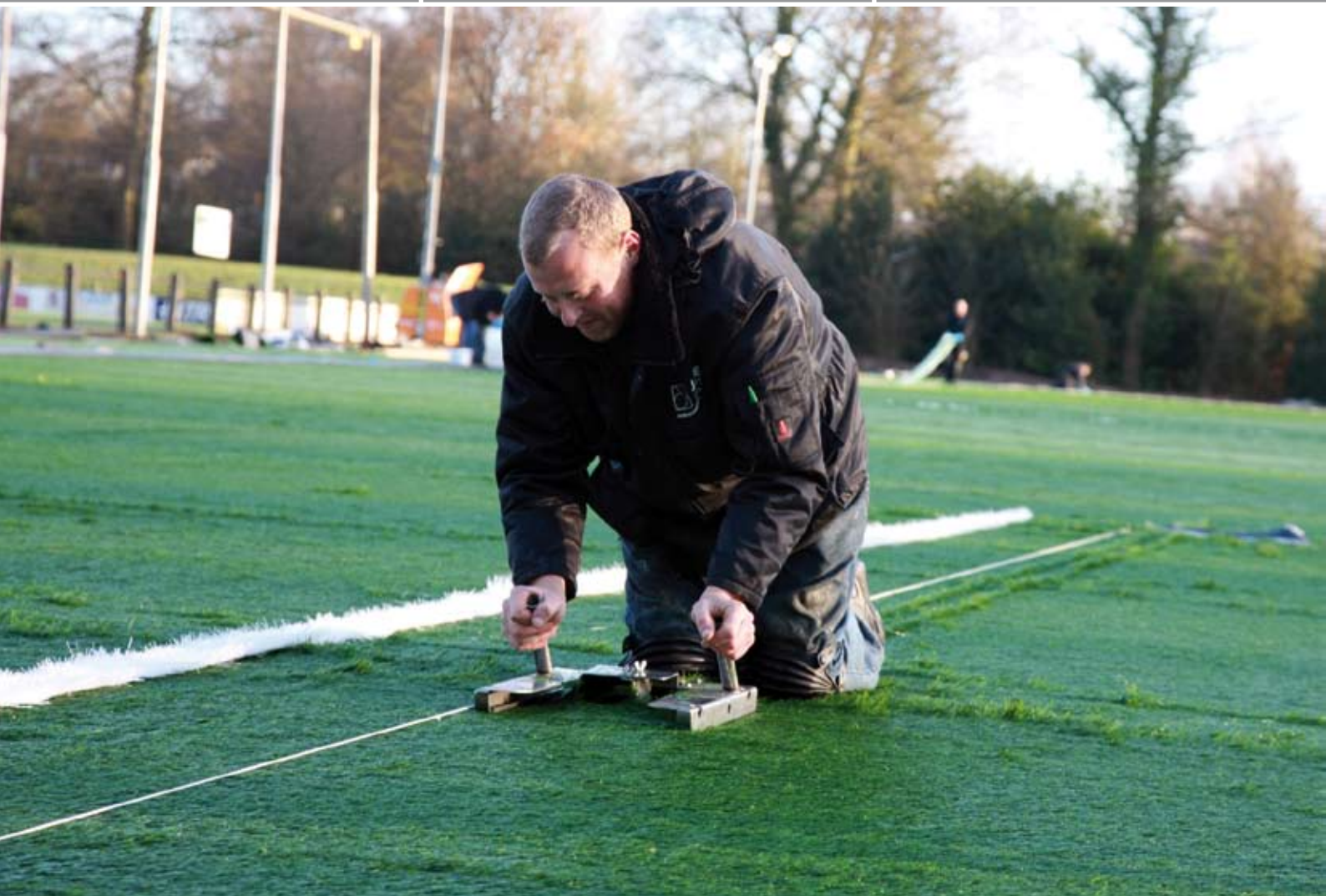
Opbrengen van het zand. Dit is rond zand, want scherp zand zou de kunstgrasvezel kunnen beschadigen.
