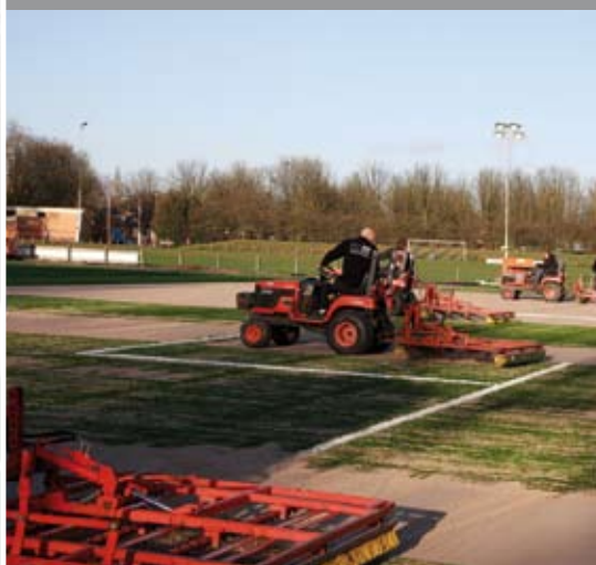
Het opgebrachte zand wordt intensief tussen de vezels ingewerkt door tractoren met een egje en bezem erachter. Te zijner tijd ruimt het team de resten en afval direct op.
