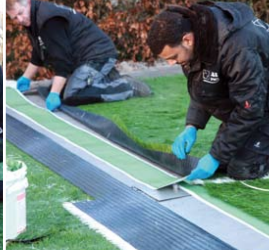
Het lijmen en aandrukken van de verbindingen lijkt een gemakkelijke klus, maar het is één van de belangrijkste dingen. Dat moet goed gebeuren.
