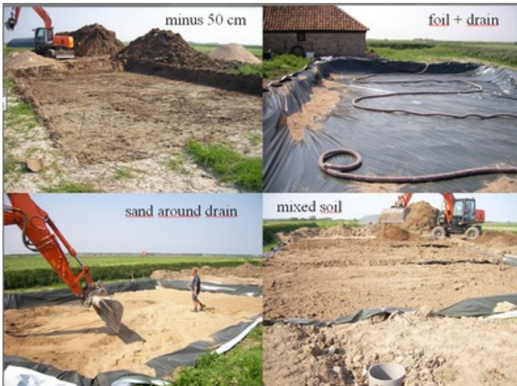
Foto 8. Aanleg van de Zilte Proeftuin waarvoor eerst 50 cm grond is ontgraven waarna een folie en drain is geplaatst. De drain is aangesloten op een put, waarna de oorspronkelijke grond (na gemengd te zijn met zand) is teruggebracht.
