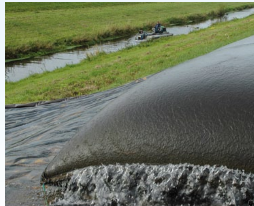
De TenCate-zak laat alleen het water door. Dat stroomt via een zeil terug naar de sloot. Als de zak vol is, blijft hij liggen. Na droging wordt de zak stukgesneden en de bagger afgevoerd. De inhoud kan ook een onderdeel worden van het landschap, omdat de zak op den duur verteert.
