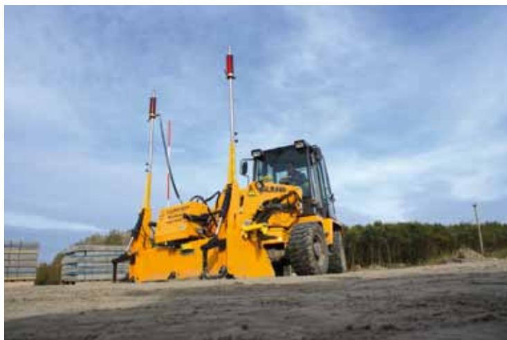
◀ Het is nog niet zo bekend dat machinaal afreien bij breedtes boven de 2,50 meter en 40 meter lengte ook verplicht is. Veldhuizen werkt hiervoor met een Frapoma-egaliseerunit.
