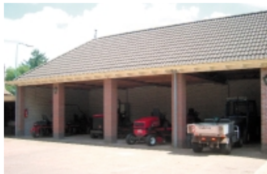
Het onderkomen van een deel van het machinepark.
