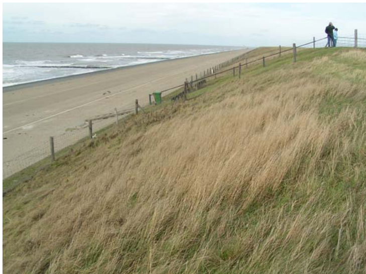
Hondsbossche Zeewering (2004); ongemaaid en onbegraasd buitentalud met ruige, open zode van Kweek.
