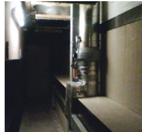
▲ De buisventilatoren krijgen een leidingensysteem met om de 5 meter een afzuigpunt voor CO 2 .
