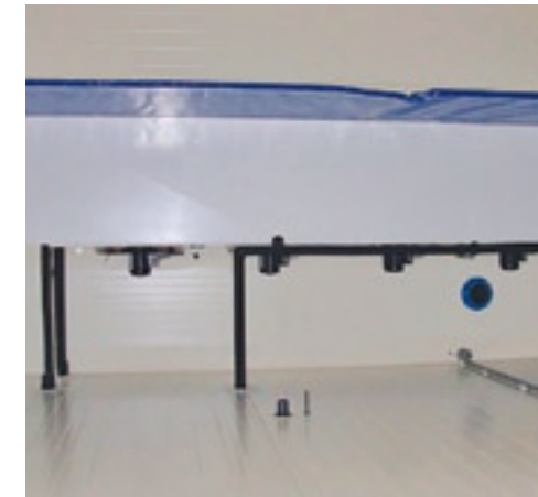
▲ Aanvoer van verse lucht met een buis achter de verdamper.
