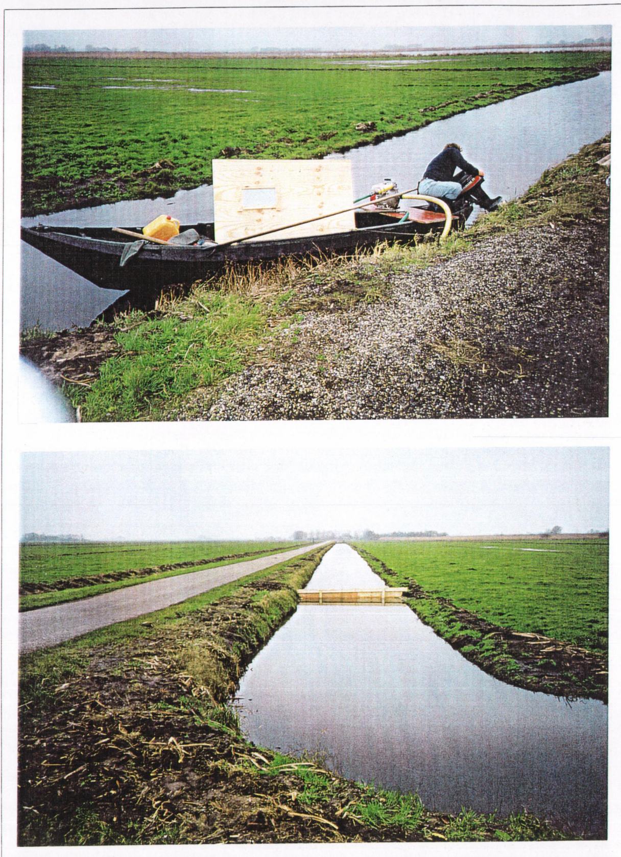
Afbeelding 3.7. Afsluiting van een aan het Duinigermeer grenzende sloot
