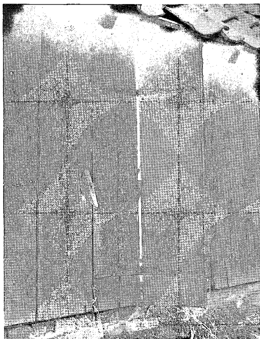
AFB. 3.14. Scharnierend staand luik in de zijwand van een tabaksschuur te Rhenen.
