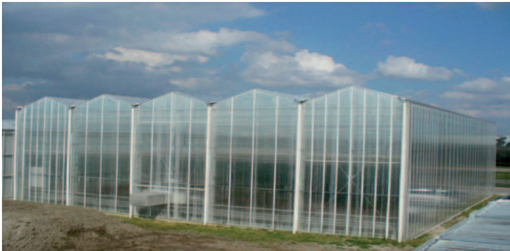
Figuur 17. De SunergieKas op het IDC
