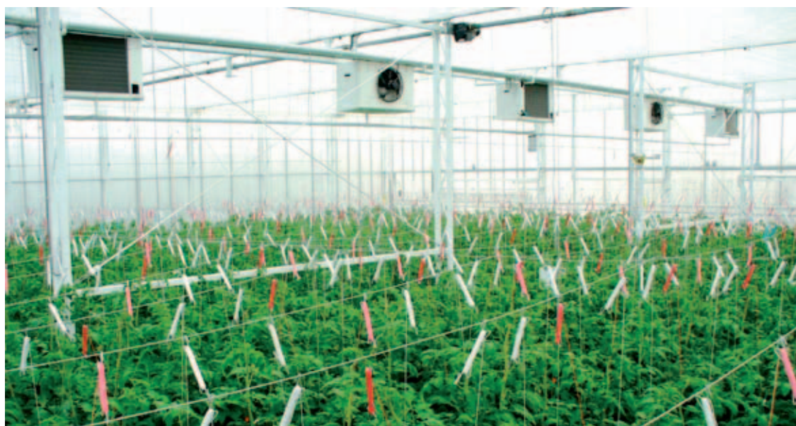
Figuur 15. Koelers bovenin de kas
