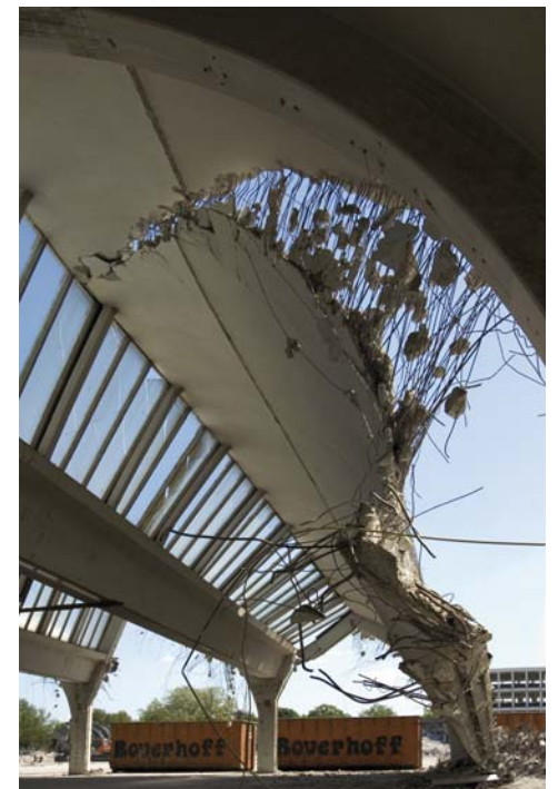
16 – HENGLO, SLOOP VAN DE SHEDSCHALEN VAN DE KON. WEEFGOEDERENFABRIEK, 2008. FOTO 2008 JAAP KROMMENDIJK
