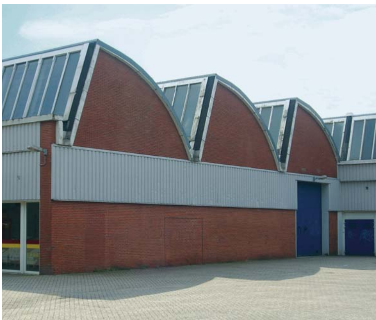
6 – BERGEIJK, SHEDSCHALEN VAN DE WEVERIJ DE PLOEG MET ESTHETISCH ADVIES VAN GERRIT RIETVELD, 1956.
