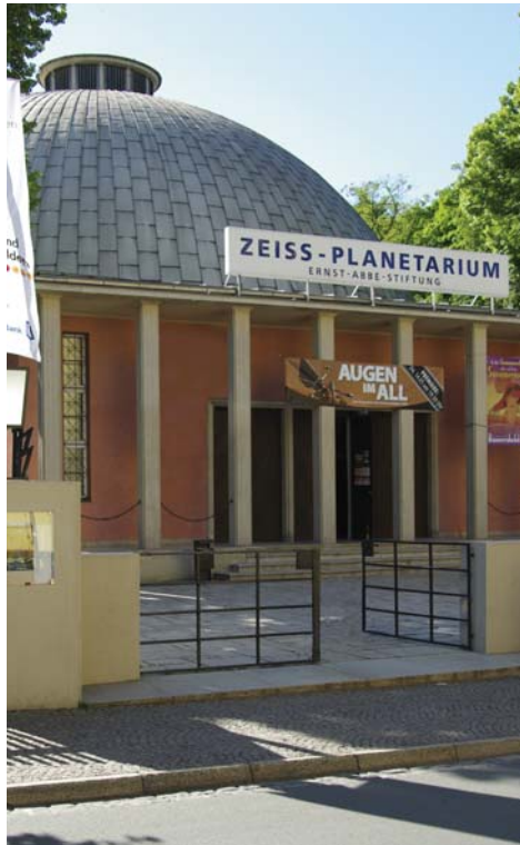
2 – JENA, PLANETARIUM GEBOUWD VOLGENS HET ZEISS-DYWIDAG-SYSTEEM, 1926.
