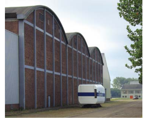
3 – ARNHEM, TONSCHALEN VAN DE DRIEBEUKIGE STROLOODS VOOR DE ALGEMENE KUNSTZIJDEN INDUSTRIE IN DE KLEEFSE WAARD, 1942.
