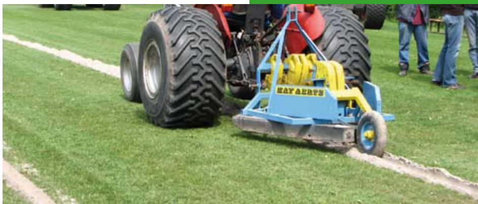
De sleuf wordt met een wiel tot onderin verdicht
