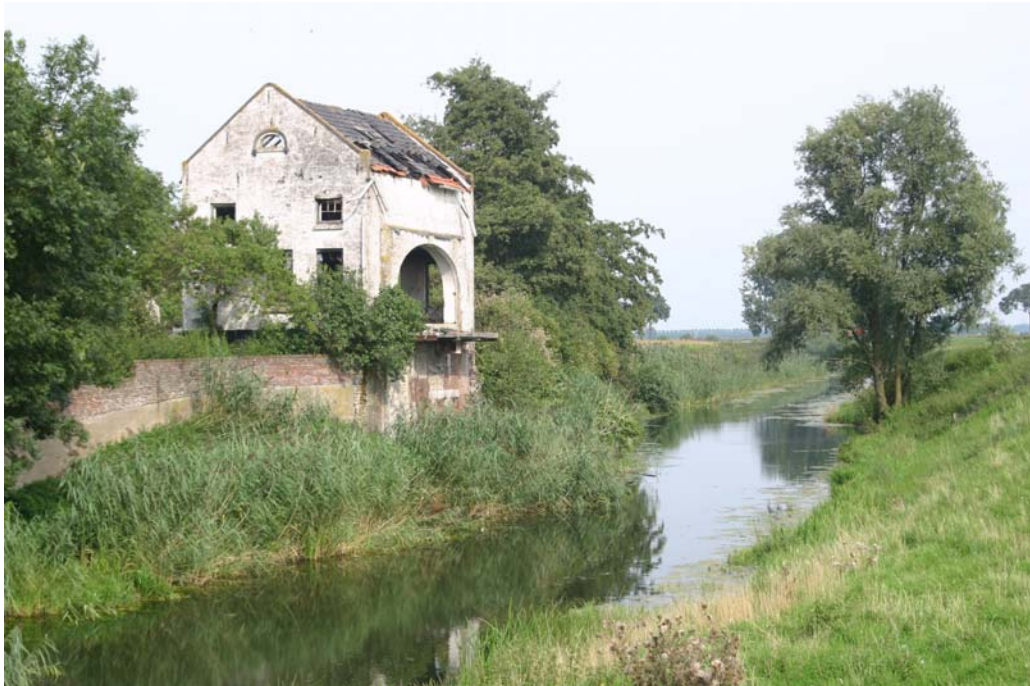
De Rode Wetering bij Gewande (Noord-Brabant) met de ruïne van het omstreeks 1880 gebouwde stoomgemaal.
