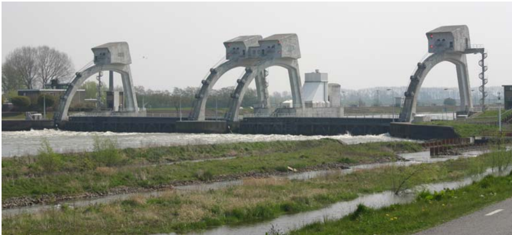
De Vizeerstuw in de Lek bij Hagestein is aangelegd in het kader van de kanalisatie van de Lek.
