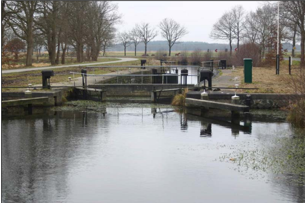
Schutsluis tussen de Kolonievvaart en de Norgervaart, ten westen van Assen. Via het stelsel van wijken en kanalen werd de turf uit de veengebieden afgevoerd.
