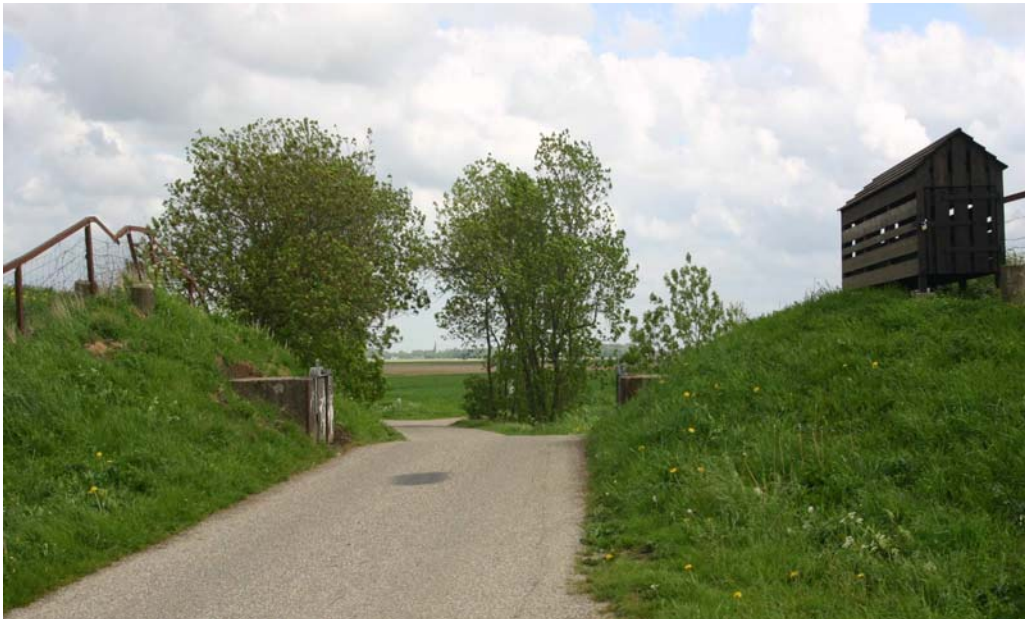
Ulrum (Groningen), coupure met schotbalkenloods in de Oude Provinciale Dijk.
