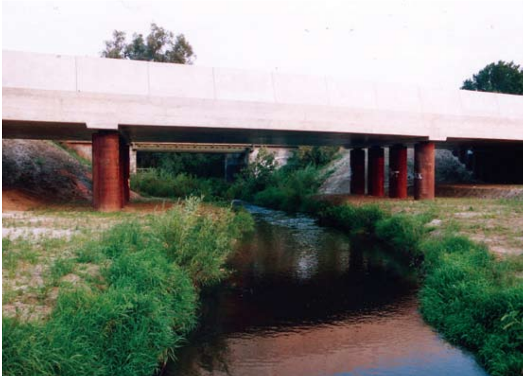
Nieuwe pijlerbrug van de snelweg A73 over de Swalm in Limburg: goed voorbeeld van ontsnippering voor otters en andere dieren: ook met hoogwater zijn er aan weerskanten droge oevers beschikbaar.
