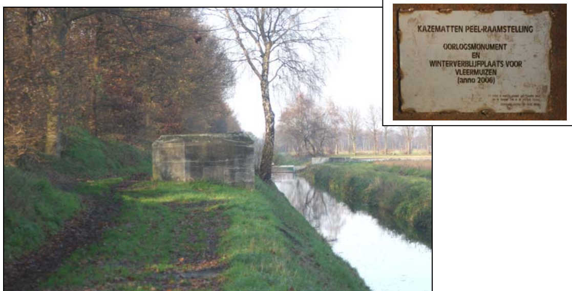
Het defensiekanaal en een van de kazematten van de Peel-Raamstelling. Het bord geeft aan dat de kazemat inmiddels een vreedzame bestemming heeft gekregen.
