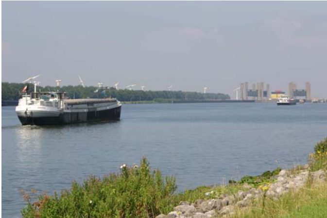
De Rijn-Schelde Verbinding met de Kreekraksluizen
