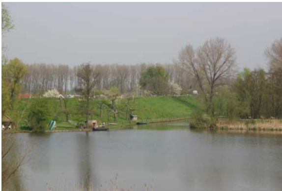
De Diefdijk bij Leerdam
