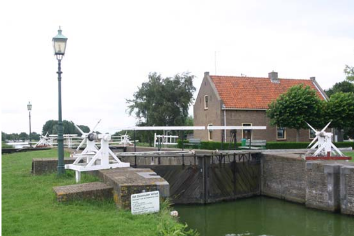
Schutsluis tussen de Rotte en de Hennipsloot naar Zevenhuizen.
