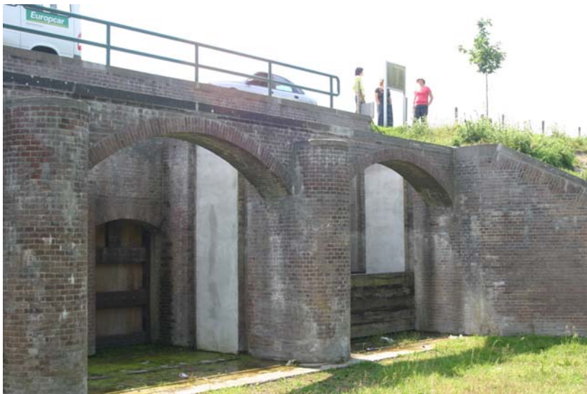
Inundatiesluis in de ringdijk van de Beemster. Via deze sluis kon water uit het Noordhollandsch Kanaal in de Beemster worden ingelaten.
