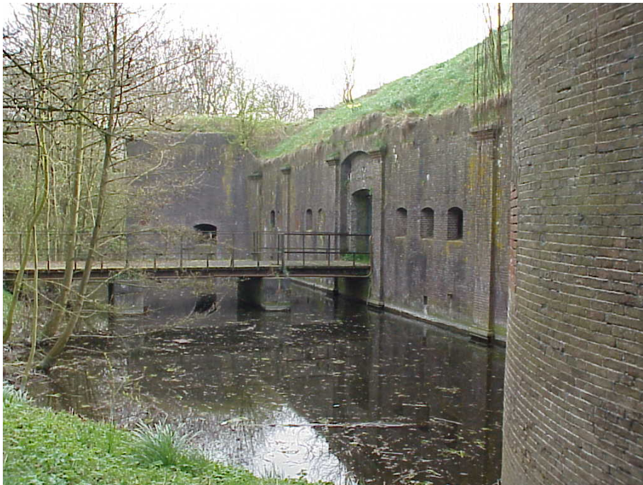
Fort Vechten ten oosten van Utrecht, onderdeel van de Nieuwe Hollandse Waterlinie.
