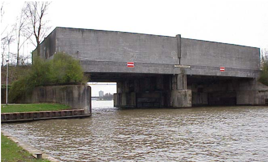
De Plofsluis (1940) in het Amsterdam-Rijnkanaal is het laatste werk van de Nieuwe Hollandse Waterlinie.
