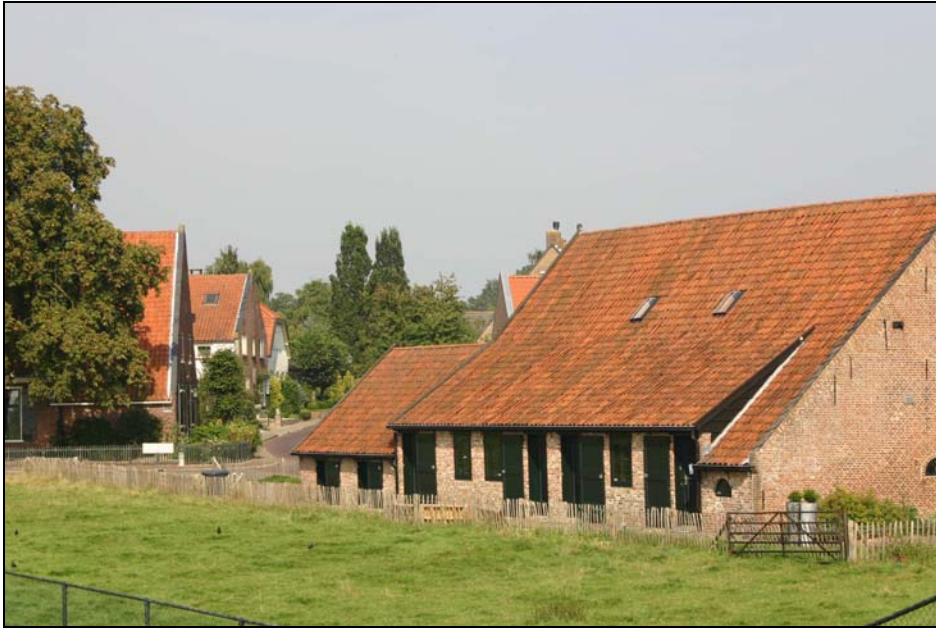
Tabaksschuur in Amerongen.
