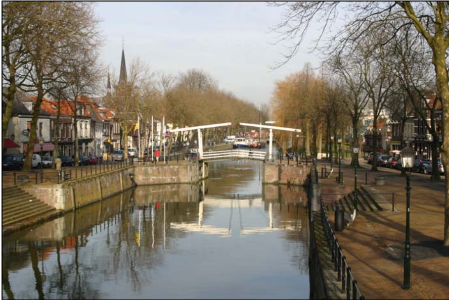
De Oude Sluis in Vreeswijk. Het dorp Vreeswijk is een topper op het gebied van de waterstaatgeschiedenis. Er bevinden zich maar liefst drie sluiscomplexen op een steenworp afstand van elkaar, terwijl in de nabije omgeving nog verschillende andere waterstaatkundige elementen liggen.
