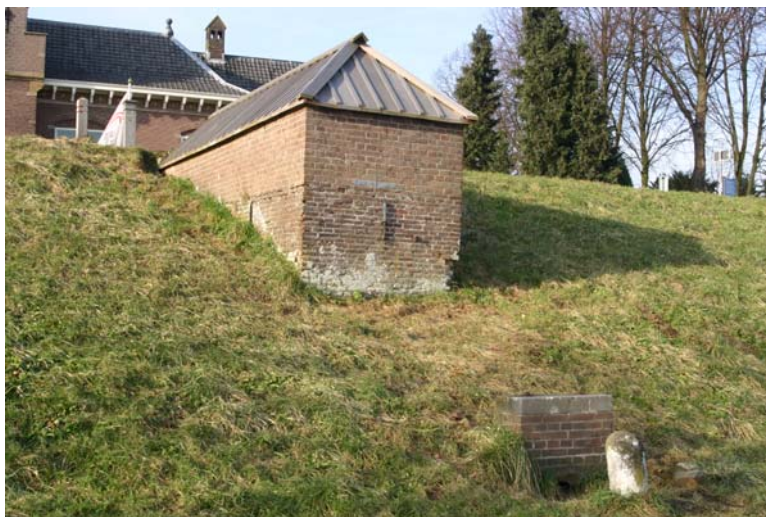
Peilschaalhuisje in Jaarsveld. Op de voorgrond is de inlaat van het water te zien. Via een buis liep het rivierwater bij hoge waterstanden het peilschaal-huisje in. Daarin bevond zich de peilschaal waar de dijkwachter de waterstand kon aflezen. Op de achtergrond is de waakhuispaal te zien (voor de vlag van het hoogheemraadschap De Stichtse Rijnlanden) en een deel van het dijkhuis van het vroegere hoogheemraadschap Lekdijk Benedendams.
