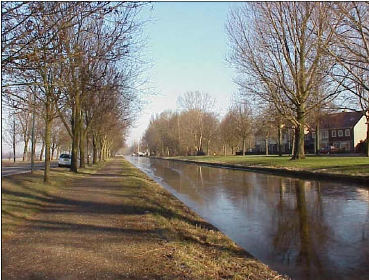
Het zuidelijke, gegraven deel van de Grecht in Woerden. Verder noordelijk ziet de Grecht er heel anders uit: daar is gebruik gemaakt van een natuurlijke waterloop, de loop van de Oude Meije.
