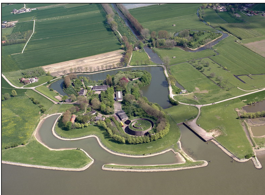
Fort Honswijk (1848) met het inundatiekanaal en de Lunet aan de Snel 1846), onderdelen van de Nieuwe Hollandse Waterlinie. In het dijkgedeelte rechts van het fort lag de hoofdinundatiesluis waarmee de inundatiekom van Schalkwijk onder water gezet kon worden. De sluis is in 1985 gedempt en gedeeltelijk afgebroken. Resten zijn in het dijklichaam opgenomen. Foto: Hoogheemraadschap De Stichtse Rijnlanden.
