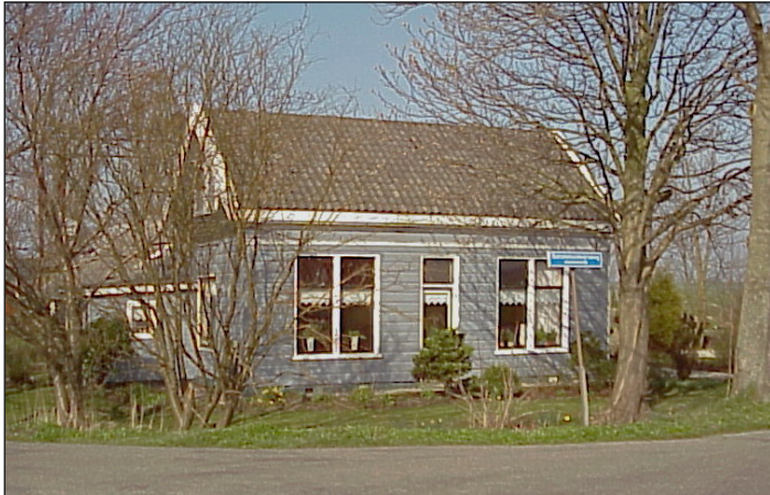
Houtbouw bij fort Waver-Amstel
