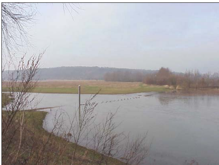
Bastions in de uiterwaarden aan de voet van de Grebbeberg, onderdeel van de Grebbelinie
