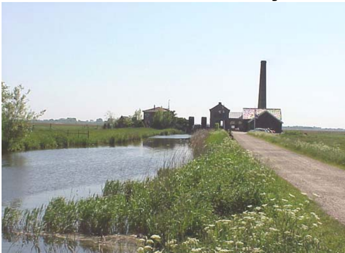
Stoomgemaal Hertog Reynout in de polder Arkemheen
