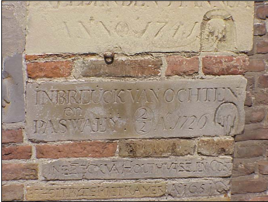
Bij een huis aan de Binnenpoort van Culemborg zijn verschillende vloedmerken aangebracht. De handjes op de stenen geven aan hoe hoog het water destijds heeft gestaan, zoals bij de overstromingen van 1657, 1726 en 1741.
