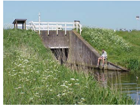
Uitwateringssluis in de voormalige zeedijk van de Polder Arkemheen
