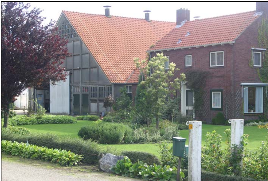
Karakteristiek boerenhof met betonnen palen bij de oprit.
