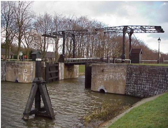
Sluisbrug over de Katerveersluis in de Willemsvaart
