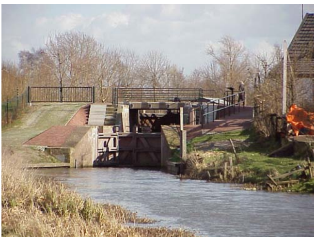
Sluis in de Oude Wetering, via welke het water werd geloosd in het Zwarte Water
