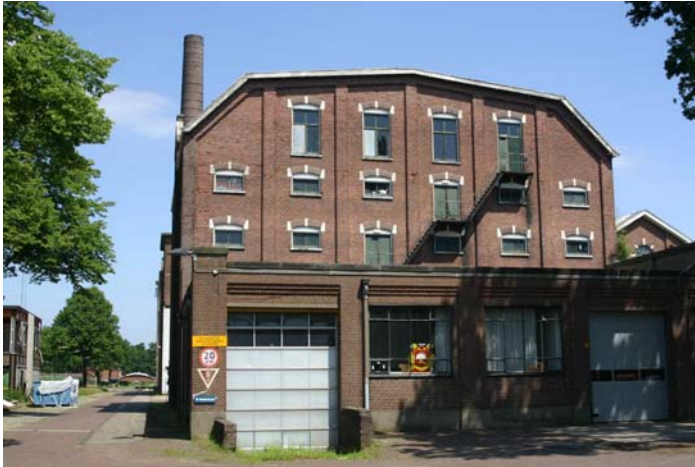
Fabrieksgebouw van de voormalige Boekelose Stoomblekerij, opgericht in 1888. Een gedeelte van het fabriekscomplex wordt afgebroken voor woningbouw, enkele markante gebouwen krijgen een nieuwe functie en worden omgebouwd tot appartementen.
